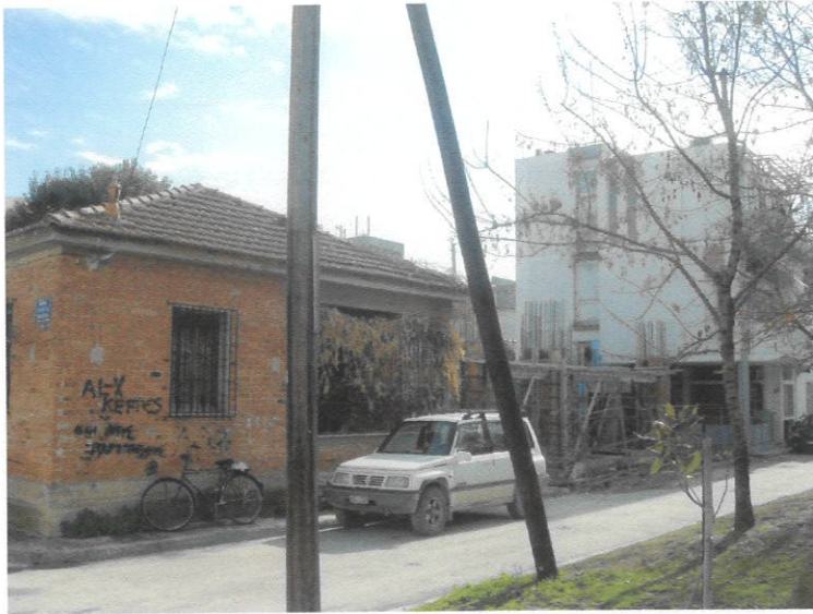
Νέα οικοδομή στο στάδιο της κατασκευής με υποδομή στοάς.
