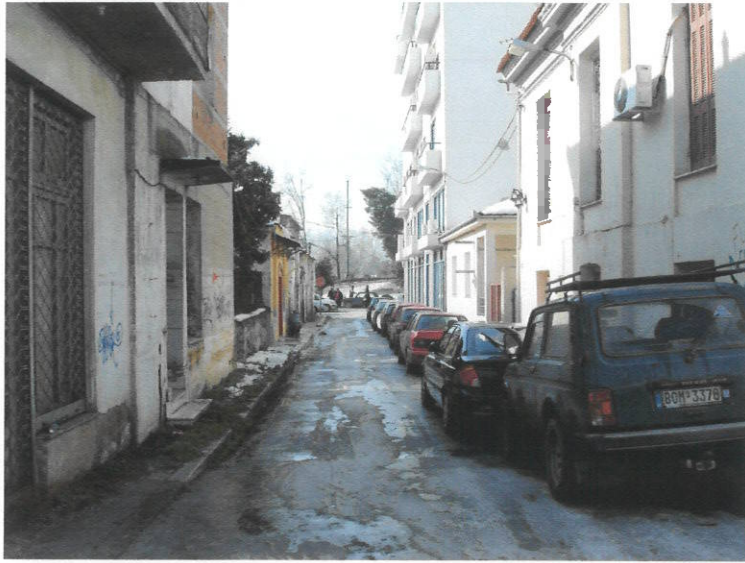
Παλιές κατοικίες σε εγκατάλειψη (αριστερά).
