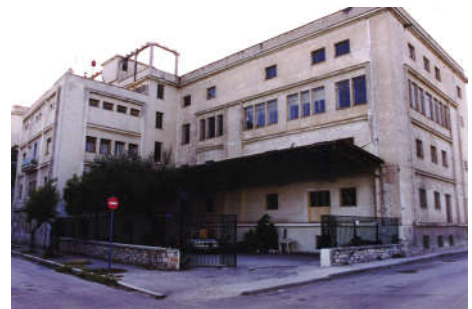
Σημερινή κατάσταση (πριν την επέμβαση)
