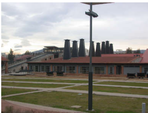
Μετά: Ιστορικό Βιομηχανικό Μουσείο Πλινθοκεραμοποιίας Κέντρο Πολιτισμού - Αναψυχής
