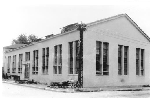
Πριν: Ηλεκτρική Εταιρία Βόλου
