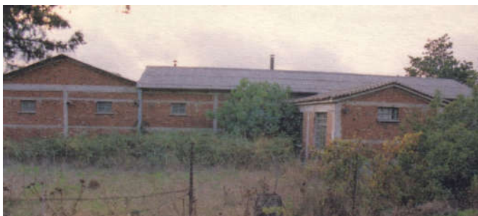
Πριν: Αποθήκες Οργανισμού καπνού (Καραγάτς)
