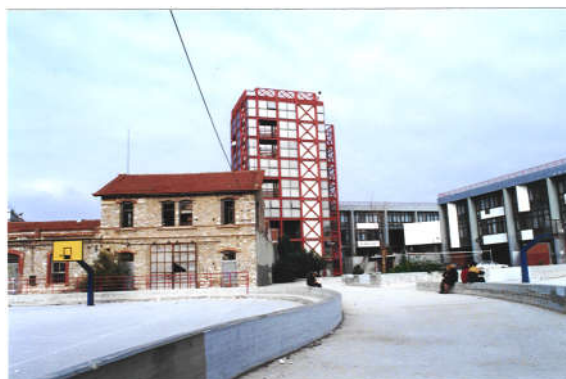
Μετά: Σχολικό συγκρότημα - Διοίκηση 1βάθμιας και 2βάθμιας εκπαίδευσης Σχολείο 2 ης ευκαιρίας
