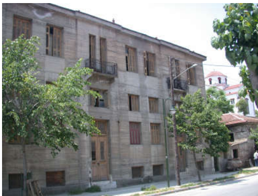
Σημερινή κατάσταση (πριν την επέμβαση)
