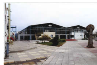
Πανεπ. Θεσσαλίας. Κτίριο Αρχιτεκτόνων
