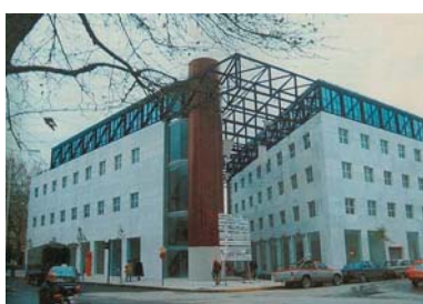
Το κτίριο του ΤΕΕ Μαγνησίας επί των οδών 2ας Νοεμβρίου - Ξενοφώντος ΠΗΓΗ: Ενημ. Δελτίο ΤΕΕ, τ. 1889, 15. 01. 1996
