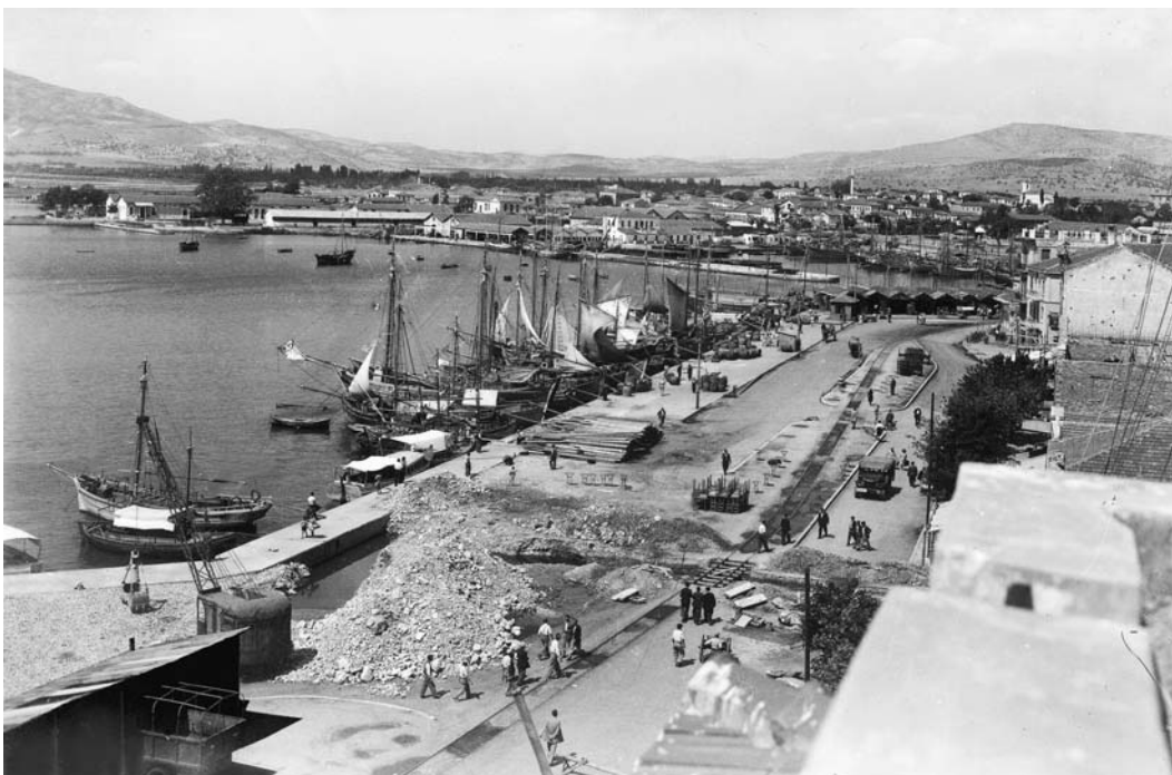
Βόλος, εργασίες στον κεντρικό προβλήτα του λιμένος, 1950. ΠΗΓΗ: ΔΗ.Κ.Ι. 2004
