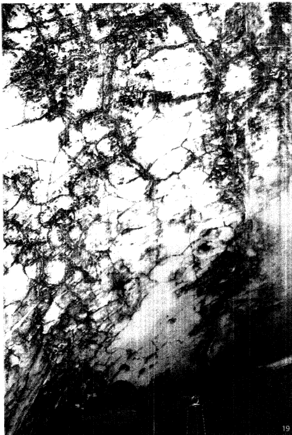
Εικ.19 Ι.Μ. Αγ. Γεωργίου στη νησί. Εισαγωγή καθοδών ρωγμές στην οροφή του Ιερου (2018)
