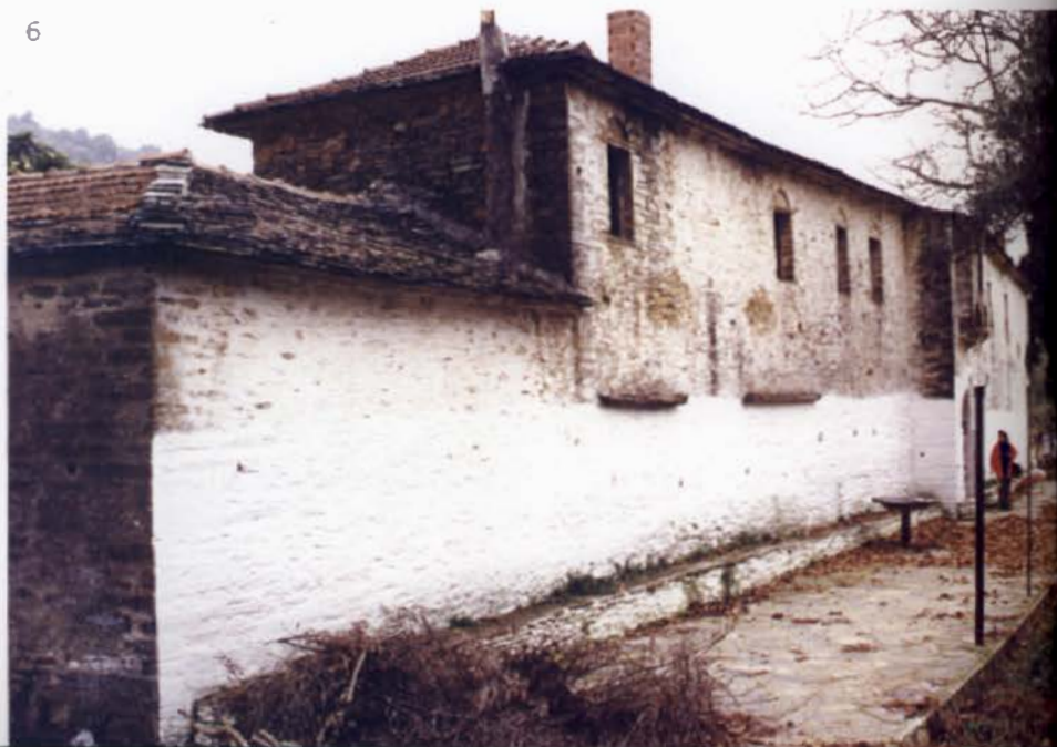
Εικ.7. Ι.Μ. Αγ. Αθανασίου Λαύκου.Δ όψη, πύλη εισόδου.
