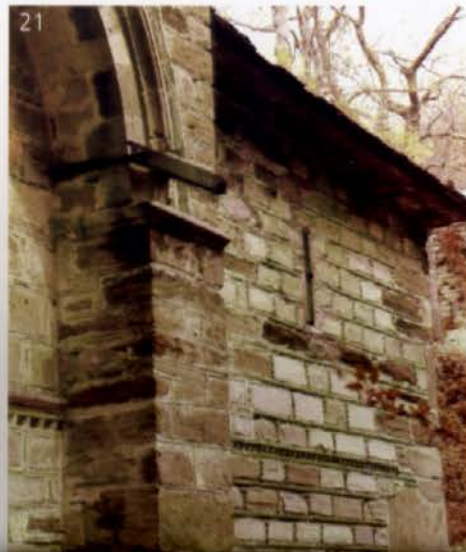
Εικ.20. Ι.Μ. Αγίου Λαυρεντίου. Καθολικό. Ν όψη. Προέχουσες παραστάδες. Εικ.21. Ι.Μ. Αγίου Λαυρεντίου. Καθολικό. Ν όψη. Λεπτομέρεια τοιχοποιίας.
