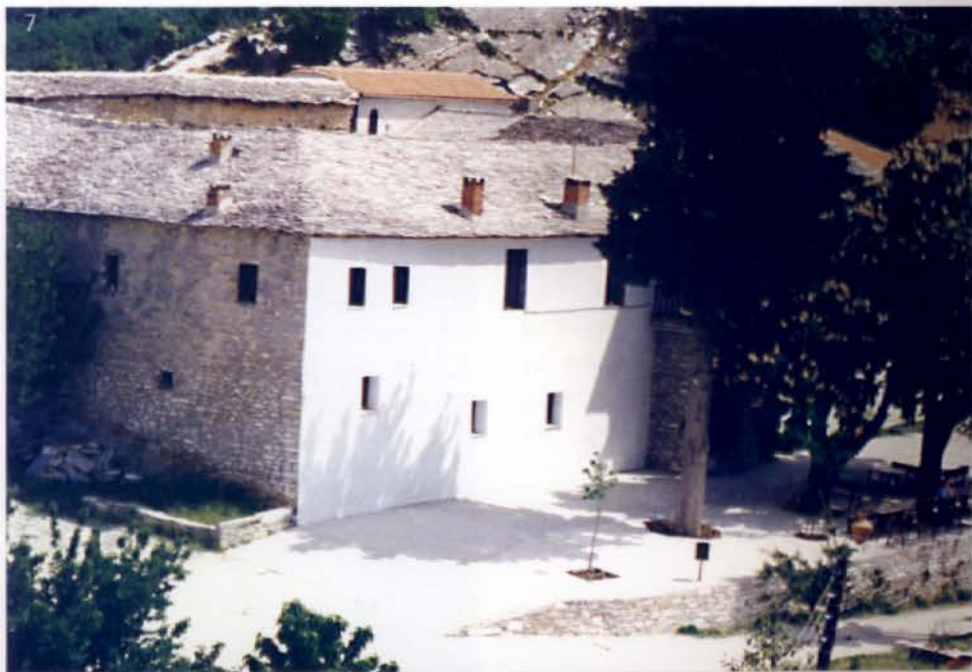
Εικ.8. Ι.Μ. Παμμεγίστων Ταξιαρχών. ΒΑ άποψη. Κλειστή στοά ορόφου στη Ν και Δ πτέρυγα. Νεόδμητο ογκώδες παρεκκλήσι στη ΒΑ γωνία.
